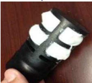
1. Om 100 mm ankarhylsa används, fyll ut groparna i hylsans botten med lim.
