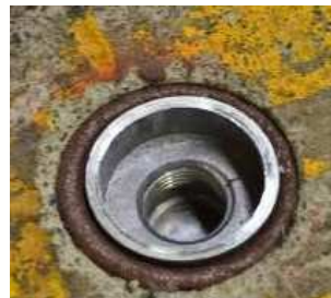
3. När limmet härdat helt, skruva loss pollaren och kontrollera limningen. Resultatet bör likna bilden ovan.
