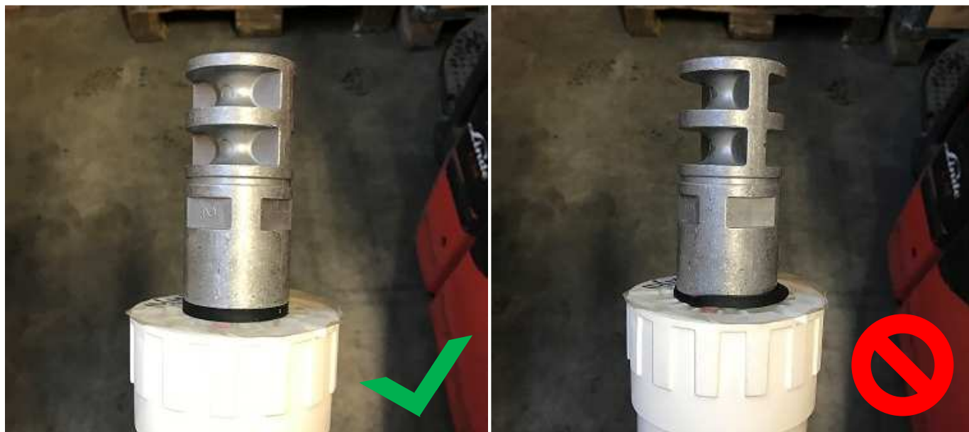
Korrekt monterad ankarhylsa, packning ej klämd.
